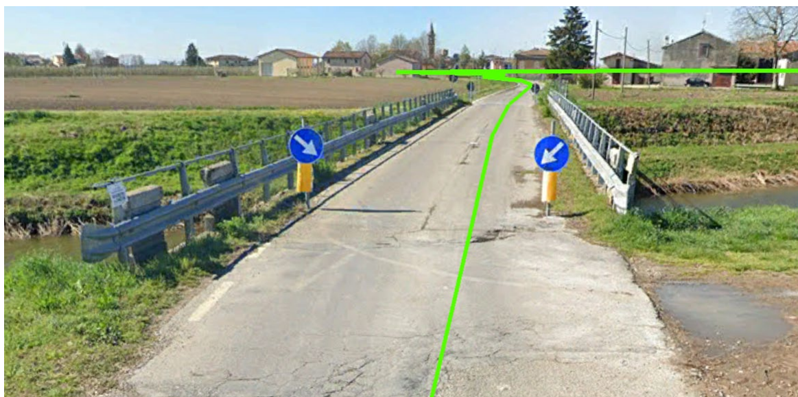
Figura 39 – Interferenza “Ponte 2” risoluzione staffaggio sul ponte
